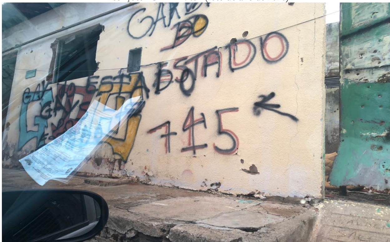
Figura 6: Muro de uma casa da Rua João Damásio, que fica no Bairro Belo Horizonte, Mossoró, com inscrições “GDE” “745” (foto do ano de 2020)
